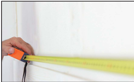
01 Measure the wall 请用卷尺测量墙壁，计算出安装面积和需要多少块石板
