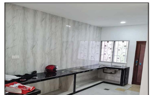
Install Done 安装完成。
