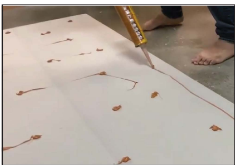
04 Apply maxbond 628 MS polymer on the back PVC Marble Sheet 在PVC大理石板背面涂抹 maxbond 628 MS 聚合物
