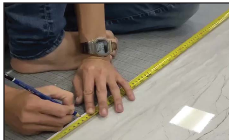
02 Marking On PVC Marble Sheet 在PVC大理石板上，画下尺寸
